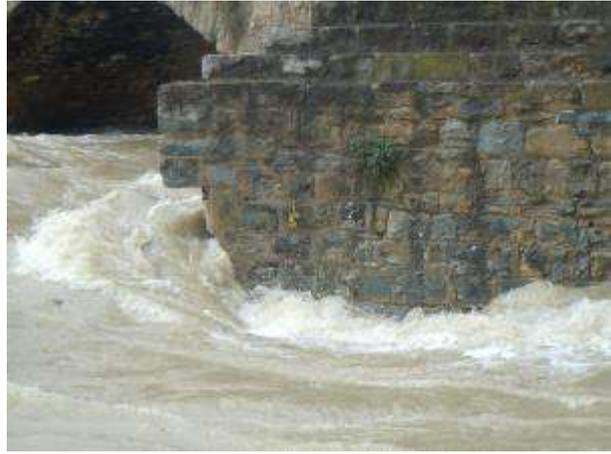
En el Puente de Santa Engracia el nivel del agua llegaba a la coronación del ojo izquierdo, pero los otros dos todavía tenían una importante capacidad de desagüe. Puede verse la pérdida de carga que originaba la sección del puente y la consiguiente elevación aguas arriba.
